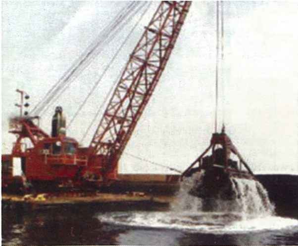
Şekil 5. Gölde sediment uzaklaştırılması
